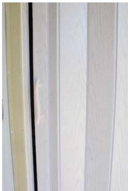
Las puertas que separan la sala de elaboración con la de envasado y la puerta de la cámara son lisas y no absorbentes. Las puertas del aseo, del laboratorio y de acceso a la sala de elaboración son de fuelle en PVC.
