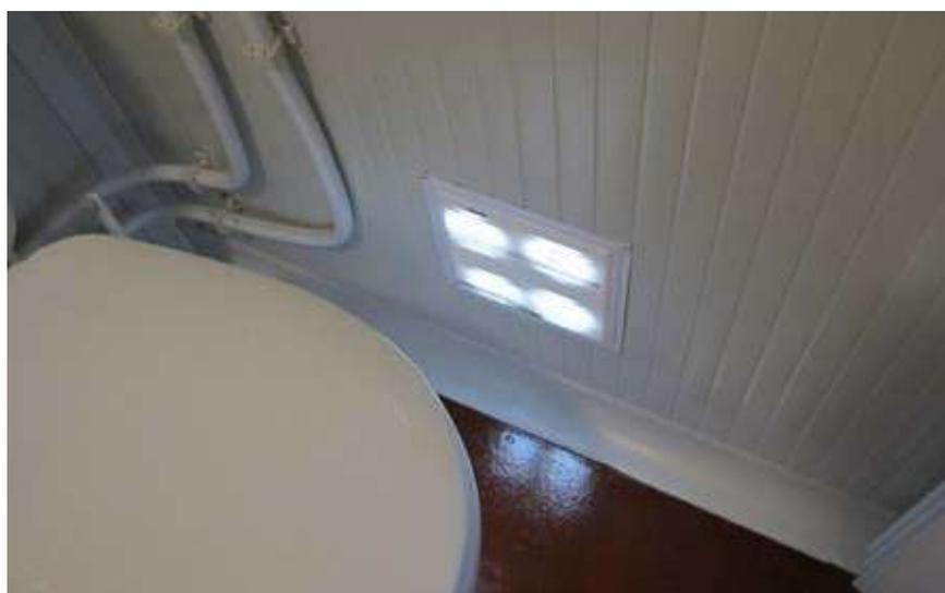
El aseo dispone de dos aperturas para ventilación natural debidamente protegidas para evitar entrada de insectos. La sala de elaboración y la sala de envasado y ventas disponen de una ventana provista de mosquitera.
