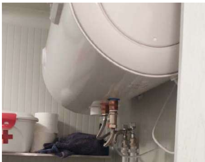
Fig. 3.3.17 ► Termo eléctrico.
