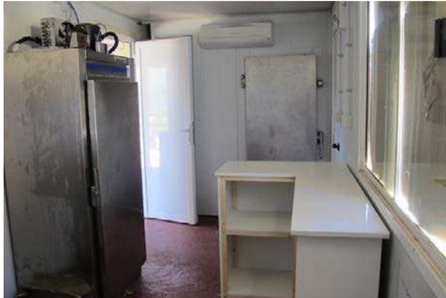
Fig. 3.3.21 ▶ Sala de envasado y venta (terminando los trabajos). Al fondo se encuentra la cámara de afinado y a la izquierda la sala de elaboración.
