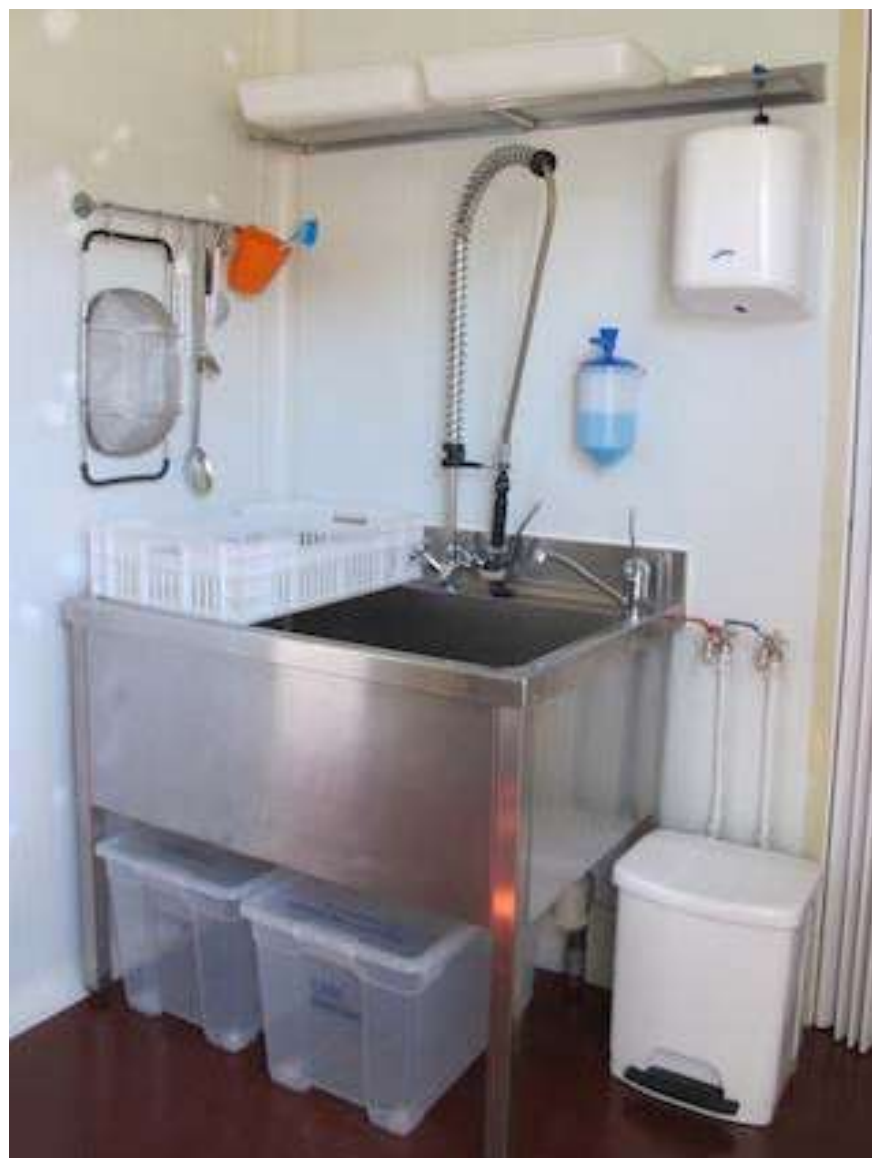
Fig. 13 ▶ Único fregadero/lavamanos "multiuso" en pequeña sala de elaboración.
