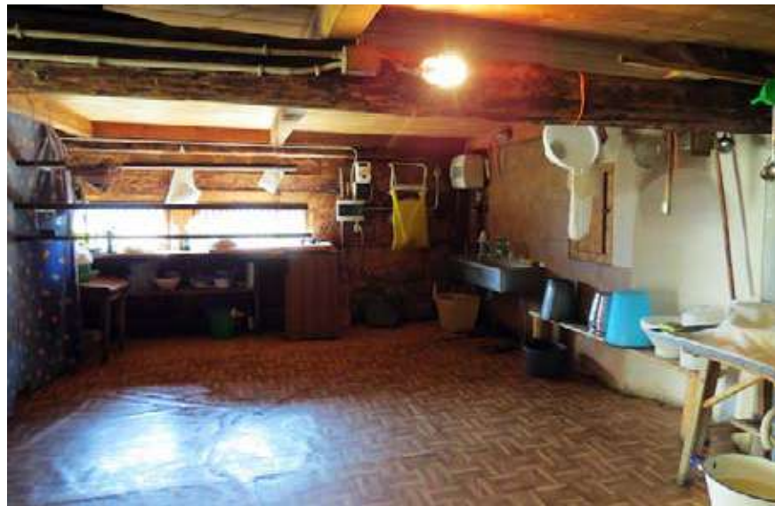
Fig. 19 ▶ Sala de elaboración multifuncional sin desagüe en el suelo.
