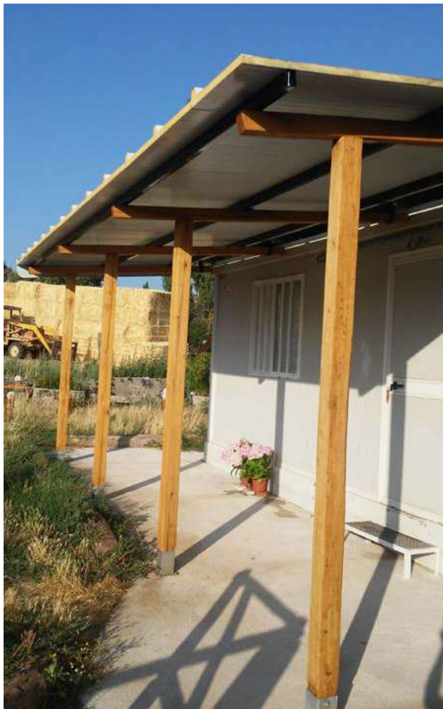
Fig. 3.3.01 ► Fachada de la quesería (en construcción).
