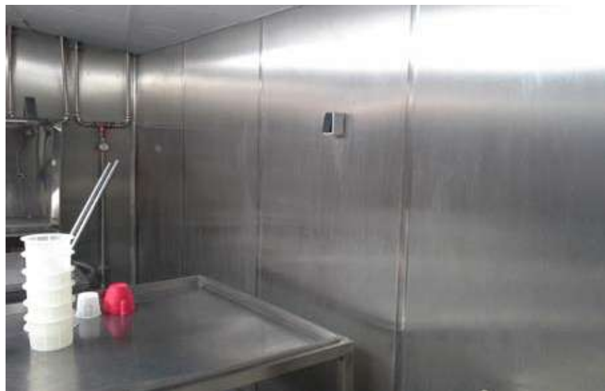
Fig. 3.2.09 ▶ Paneles metálicas de la pared.
