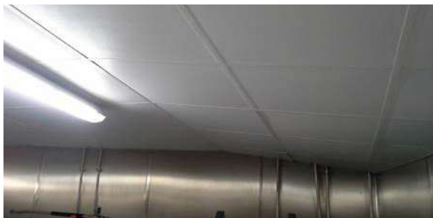
Fig. 3.2.10 ▶ Techo de paneles.
