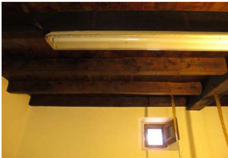
Fig. 3.1.13 ▶ Techo de madera.
