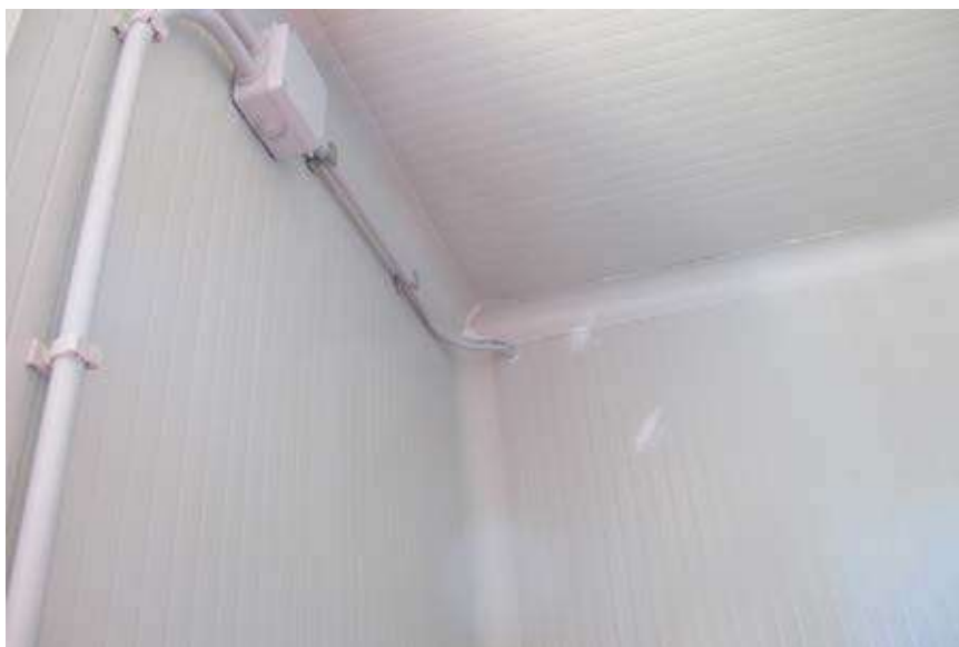
Fig. 3.3.10 ▶ Techo con bordes redondeados.
