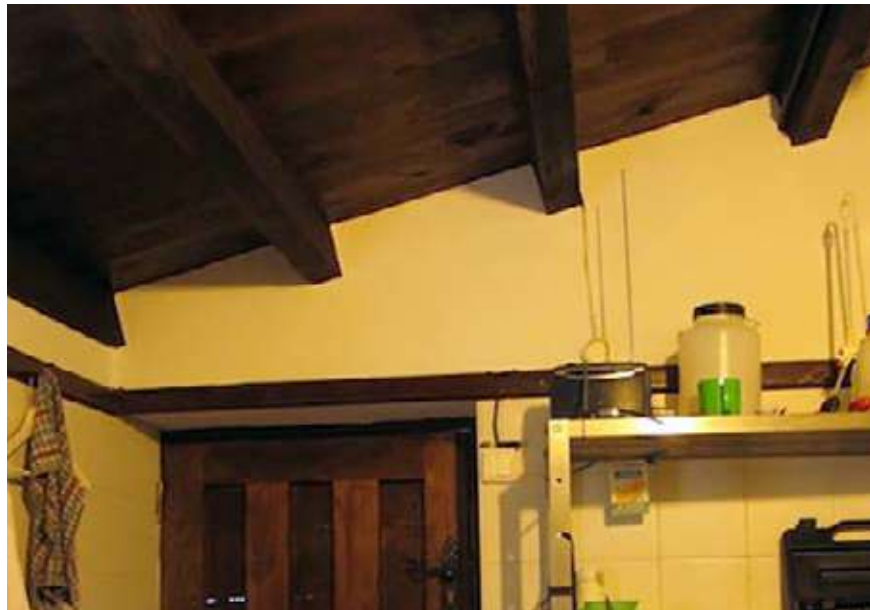
Fig. 21 ▶ Techo de madera en sala de elaboración.
