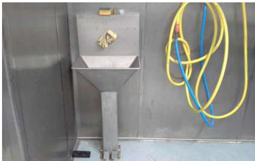
Fig. 3.2.05 ▶ Lavamanos en sala de elaboración.
