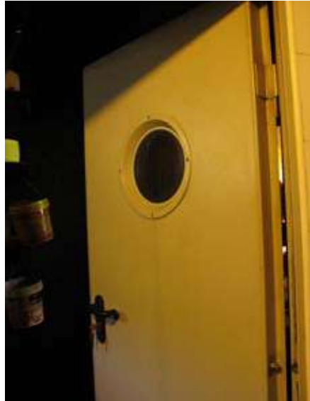
Fig. 3.114 ► Puerta de hierro de separación entre sala de elaboración y el ahumadero.
