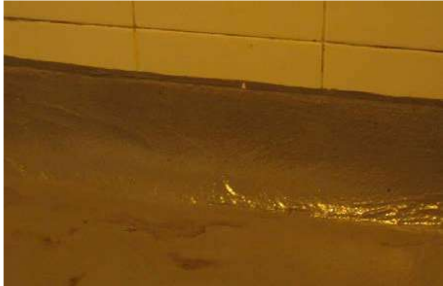
Fig. 3.1.09 ▶ Suelo epoxi con ángulo redondeado (realizado voluntariamente).
