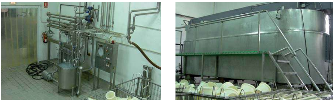
Imagen 3.1. Distintas instalaciones de una industria láctea de elaboración de queso.
