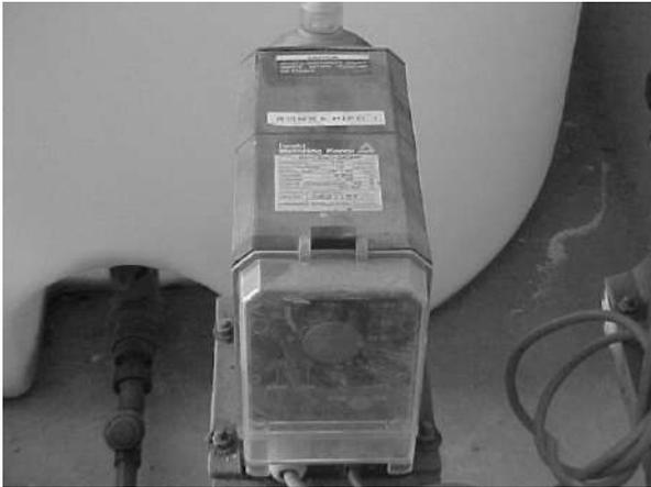
FIGURA 14. Bomba dosificadora de hipoclorito (Aigües del Prat, SA).
