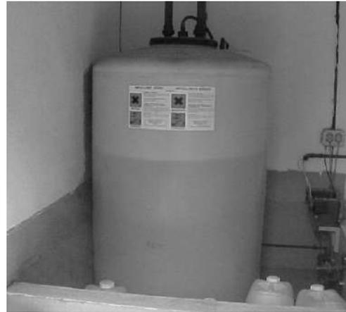
FIGURA 15. Depósito de hipoclorito (Aigües del Prat, SA).
