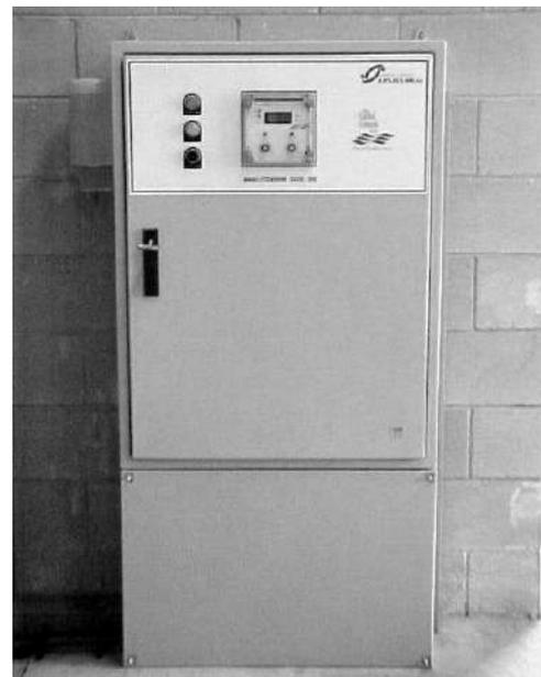
FIGURA 16. Analizador automático de cloro (Aigües del Prat, SA).
