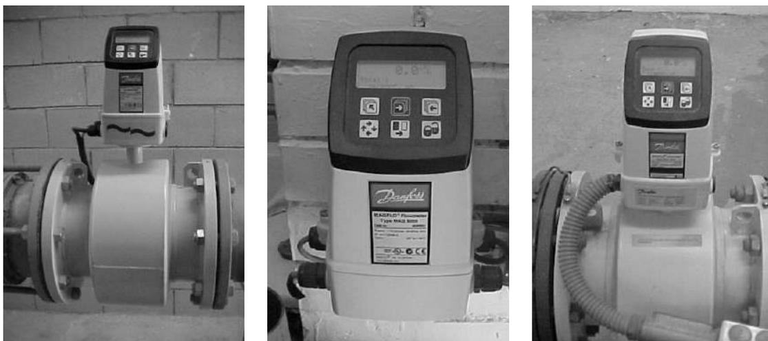
FIGURA 17. Contadores de caudalímetros en tuberías (Aigües del Prat, SA).
