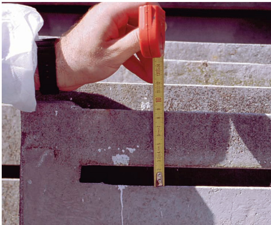
▲ Figura 18. Los suelos de hormigón deben cumplir los requisitos especificados en la normativa.
