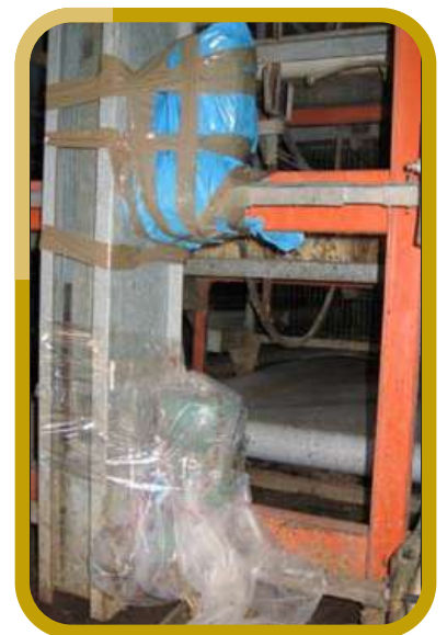
Protección de sistemas eléctricos y piezas delicadas en el proceso de limpieza.
