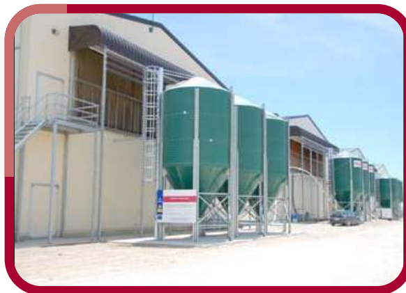
Cabeceras de nave con los silos de pienso y sistema de ventilación con paneles
